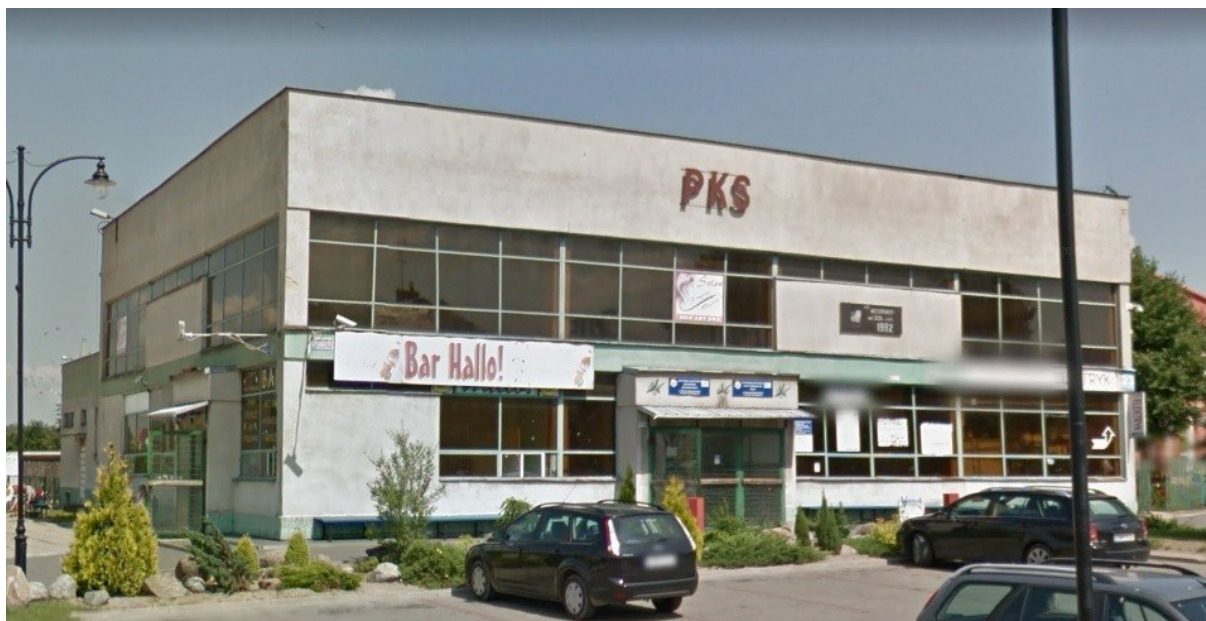
Rysunek 22. Upadający budynek dworca PKS wymagający natychmiastowej rewitalizacji i zapewnienia stabilnych warunków dla rozwoju lokali usługowych na jego terenie. (źródło: www.google.pl/maps )
